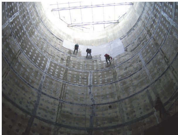
Рисунок 2 – Гидроизоляция трещин и выходов соединительных шпилек арматуры в уравнивательной емкости Кашхатау ГЭС
